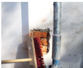
Putzfehlstellen reinigen
