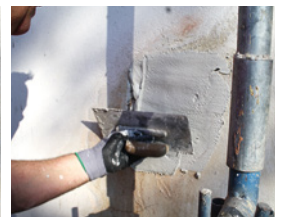
Ausputzen der Fehlstellen mit Baumit MultiWhite
