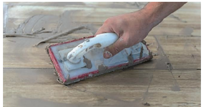
Abbildung 4: Verfugen im Schlämmverfahren
