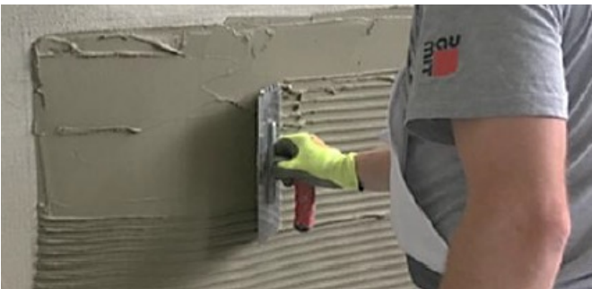
Abbildung 2: Verklebung im Buttering-Floating-Verfahren mit Murexin Flex Klebermörtel Trass KTF 55
