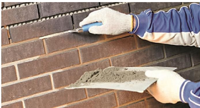
Abbildung 3: Verfugen im Fugeisenverfahren
