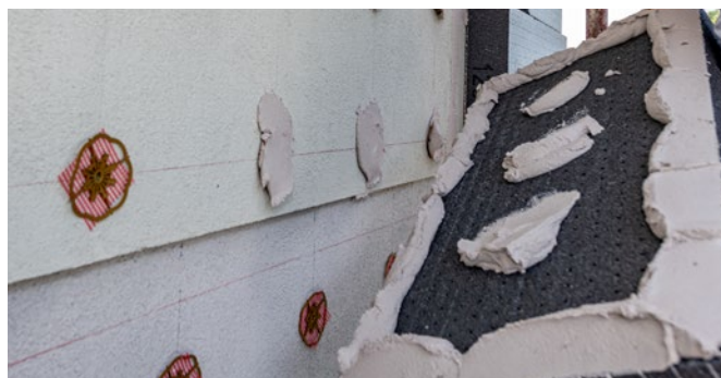
Abb. 5: Randwulst-Punkt-Methode, schematische Darstellung anhand der Baunit FassadenPlatte open air
