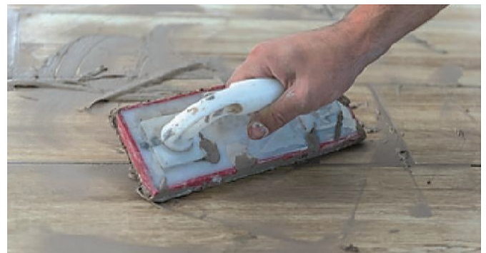
Abbildung 12: Verfugen im Schlämmverfahren
