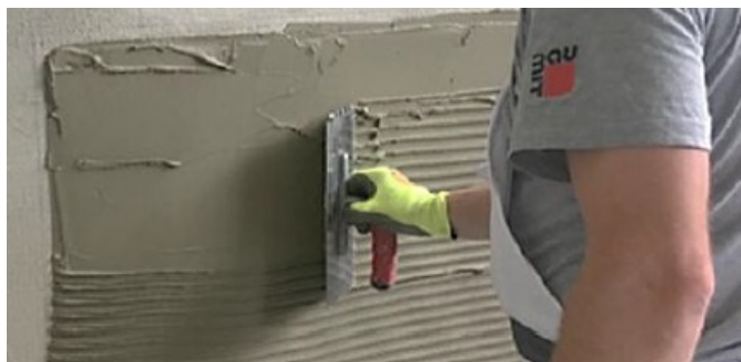
Abbildung 10: Verklebung im Buttering-Floating-Verfahren mit Murexin Flex Klebermörtel Trass KTF 55
