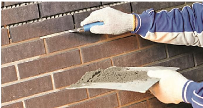
Abbildung 11: Verfugen im Fugeisenverfahren
