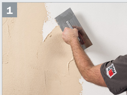
Baunit CreativTop Fine im Farbton 0356 mit einer rostfreien Stahltraufel vollflächig aufziehen.
