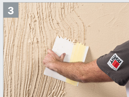
Die Fläche anschließend mittels DIY Strukturbrett 1 modellieren.
