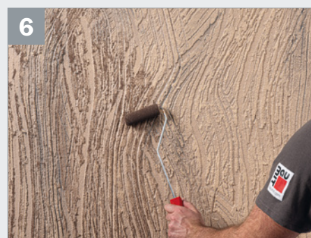
Um Akzente zu setzen, wird Baunit PuraColor im Farbton 0391 mit einem Schaumstoffroller oberflächlich aufgerollt.
