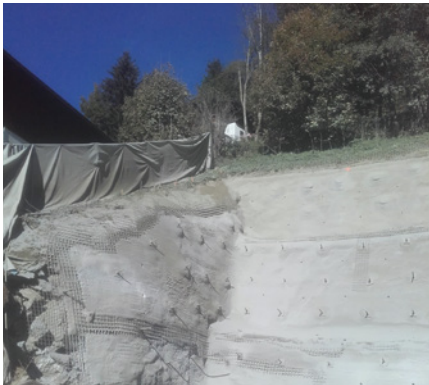
Baugrubensicherung
