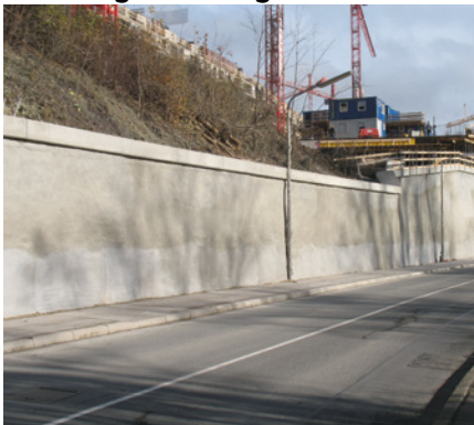
Böschungssicherung
