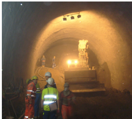
Tunnel-, Stollen und Schachtbau
