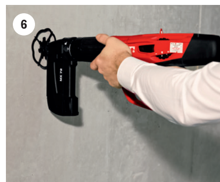
Mit Druck ansetzen und den Abzug betätigen. Der Baimit KlebeAnker X1 sitzt.
