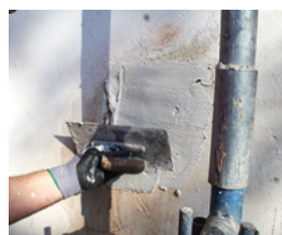
Ausputzen der Fehlstellen mit Baunit MultiWhite
