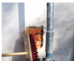
Putzfehlstellen reinigen
