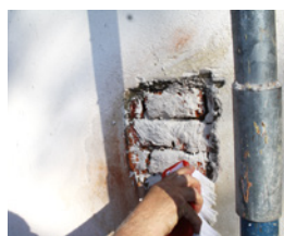
Vorspritzen auf vorgemästeten Untergrund mit Baunit MultiWhite
