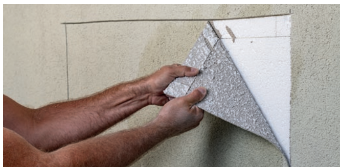
Abb. 7: Untergrundprüfung mit dem Öffnen des bestehenden Systems
