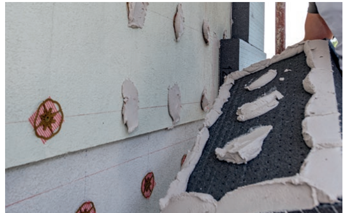
Abb. 24: Randwulst-Punkt-Methode, schematische Darstellung anhand der Bauteil-Fassade Platte open air
