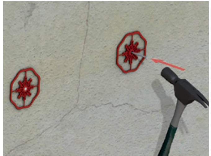
Abb. 21: Setzen der Baumit KlebeAnker mittels Hammer
