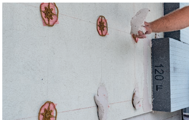
Abb. 23: Anwerfen der Kleberpatzen
