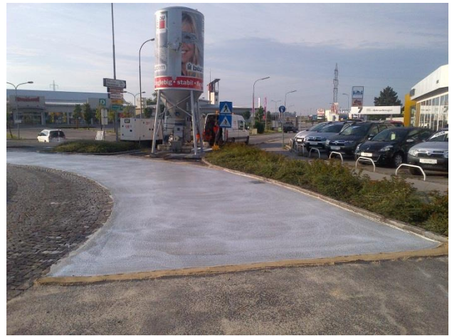
Frisch fertiggestellte Fläche mit dem "wolkigen" Erscheinungsbild des Verdunstungsschutzes
