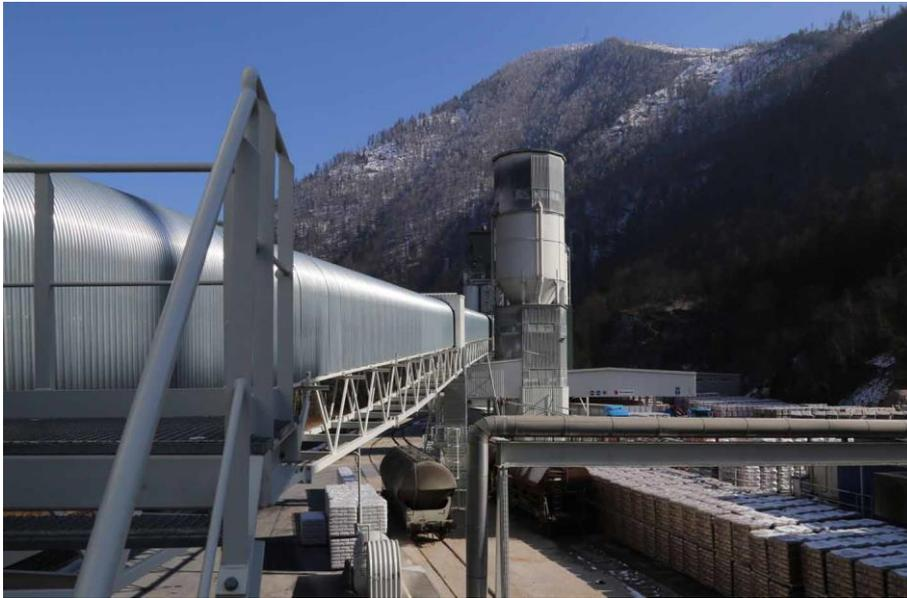
**Bildtext:** Baumit realisiert am Standort Bad Ischl eine nachhaltige Lösung für den Gesteintransport: Die innovative, 235 Meter lange Sandtransportanlage reduziert jährlich 50 t CO<sub>2</sub>, minimiert LKW-Fahrten, dämpft Staub- und Schallemissionen.
