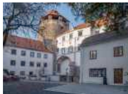
Historische Sanierung Friedensburg Schlaining, Austria
